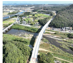
東播磨道(加古川市・三木市・小野市) [舗装工等]
