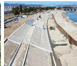
武庫川(西宮市・尼崎市) [河道拡幅]
